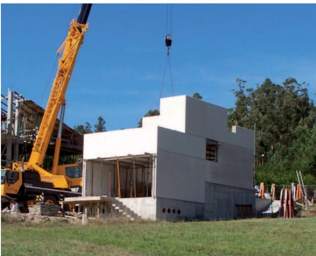
Figura 24. Colocación del segundo anillo de la estructura.
