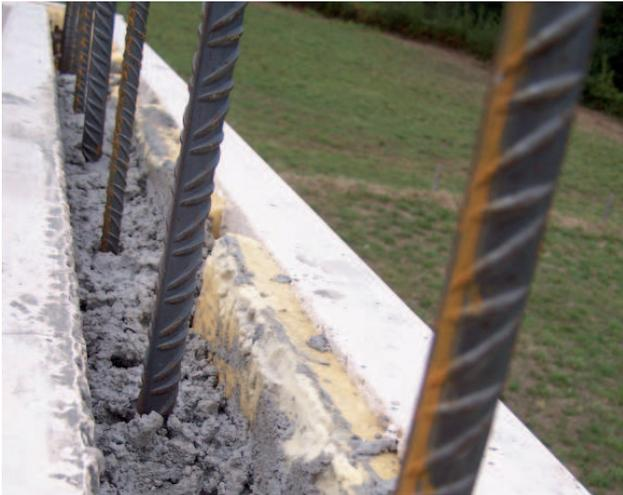
Figura 22. Detalle de los muros hormigonados y las esperas para conectar con el siguiente anillo.
