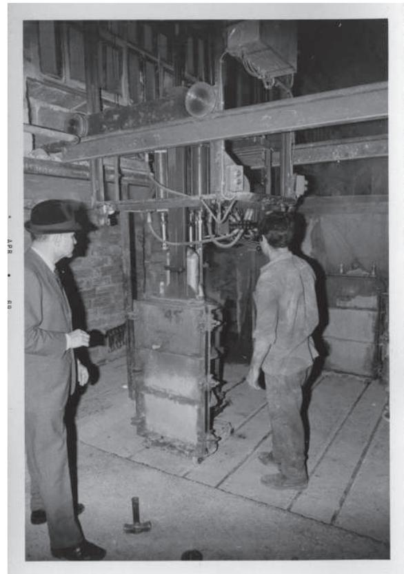
Figura 6. El interés de Fisac por los procesos de fabricación sirve de base a sus investigaciones. En estas imágenes de archivo se observan diferentes procesos vinculados a sus patentes; desmoldeo de las piezas de HUECOSA. Vic.1969 (Fig 6). El encofrado de los pilares prefabricados o recorriendo las vigas de cubierta de Getafe. (Figs 7 y 8). Getafe. 2000.
