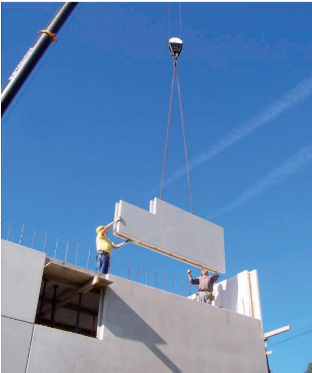
Figura 23. Colocación de paneles de geometría irregular.
