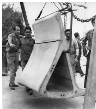
Dovela de una viga postesada de la nave de Modelos del Centro de Estudios Hidrográficos (1960-63).
