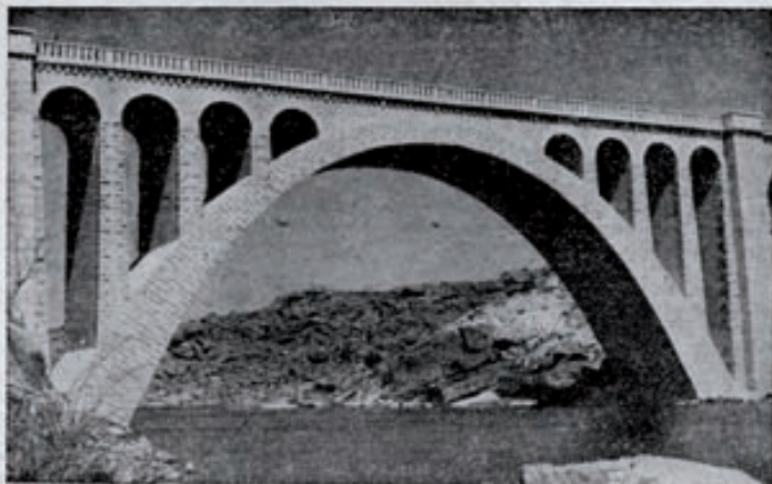
Puente de Ledesma, construido en 1951, en la carretera de Salamanca a Fermonelle, sobre el Tormes, en hormigón en masa con paramentos de sillaría. Su arco central tiene 50 metros de luz.
